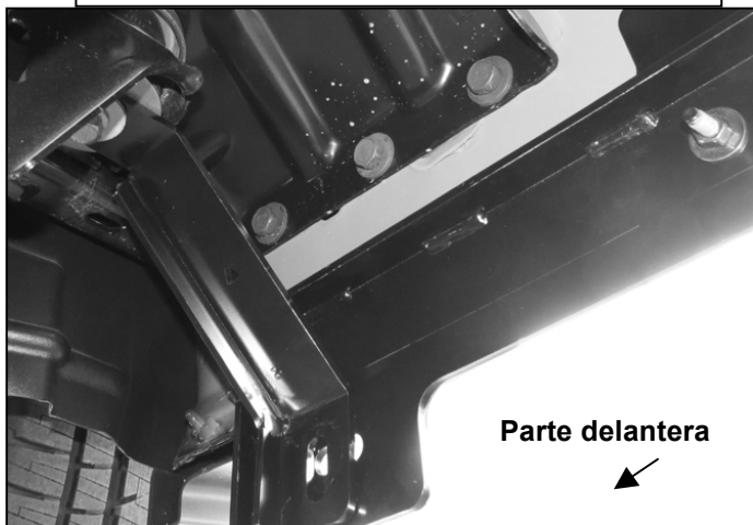
(Fig. 7) Soporte delantero del lado del pasajero sujetado al montaje de la carrocería
